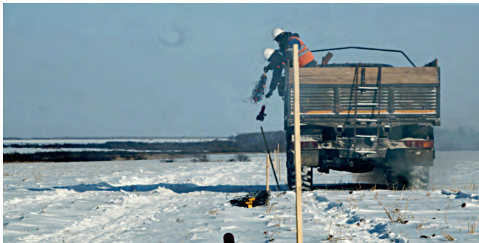
◀ Рис. 2. Подготовка профиля с оборудованием GEOTOM.
