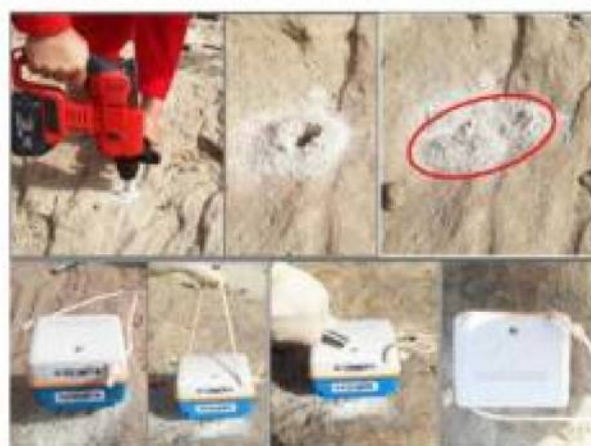
▼ Рис. 8. Установка оборудования с использованием перфоратора.
