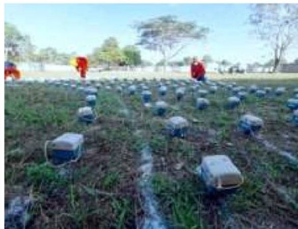
▲ Рис. 3. Подготовка круговой системы микросейсмического мониторинга строительной площадки.
