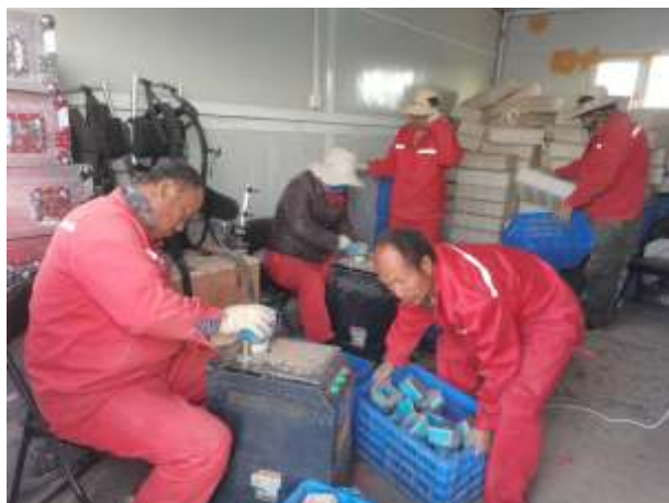
▼ Рис.8. Демонтаж IGU .
