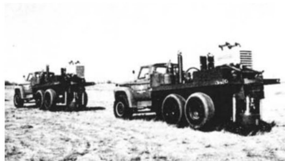
▲ Рис. 2. Кормовое расположение виброузла (1962 г.) [7].
