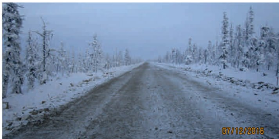
► Рис. 1. Подъездная автодорога к месторождению.
