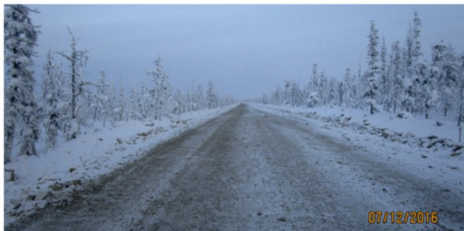
► Рис. 1. Подъездная автодорога к месторождению.
