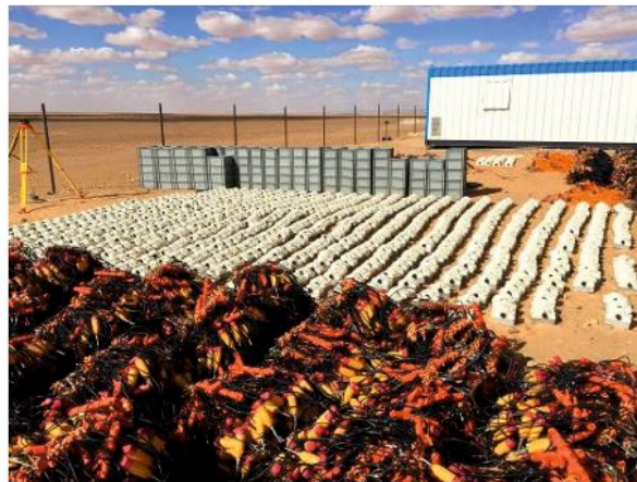
▲ Рис. 2. Пустыня Сахара. Тунис. Подготовка оборудования к работе.
