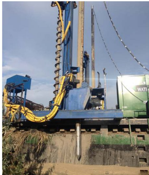
▲ Рис. 4. Буровая установка со скважинным пневматическим источником 2200LL-BHS фирмы «Bolt».
