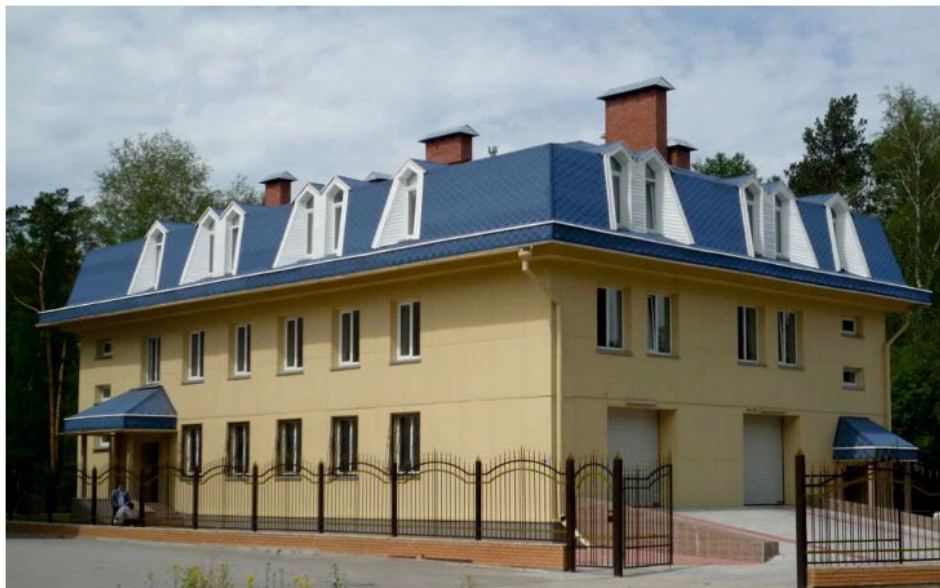
▲ Рис. 4. Административно-производственное здание ООО НПК «СибГеофизПрибор»
