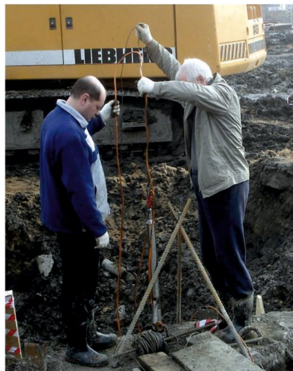
▲ Рис. 8. Проведение работ на объекте.
