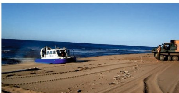
▲ Рис. 6. Вытягивание донного кабеля от раскладчика на берег с помощью СВП.
