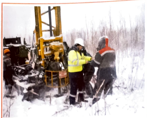
Рис.3. Супервайзер по ОТ ТБ и ООС проводит аудит буровзрывного отряда.
