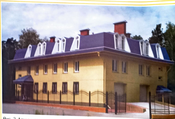
Рис. 2. Административно-производственное здание ООО НПК «СибГеофизПрибор»
