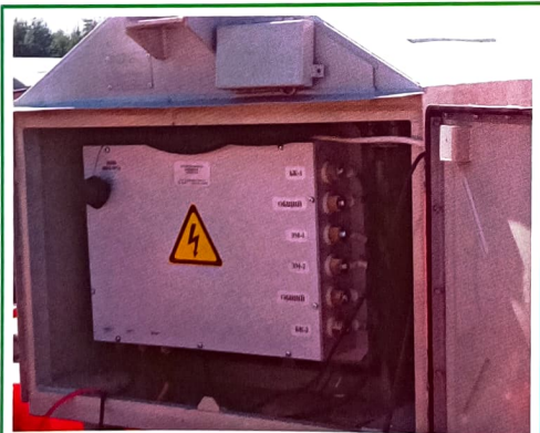
Рис. 8. Устройство заряда-разряда «4 kW, 380 V».
